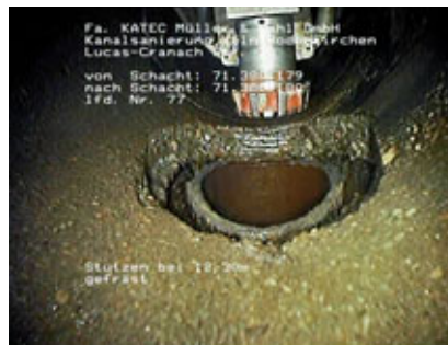
Abb. 3 Stützen in der Kanalsohle, links nach dem Fräsen, rechts nach der Sanierung.
