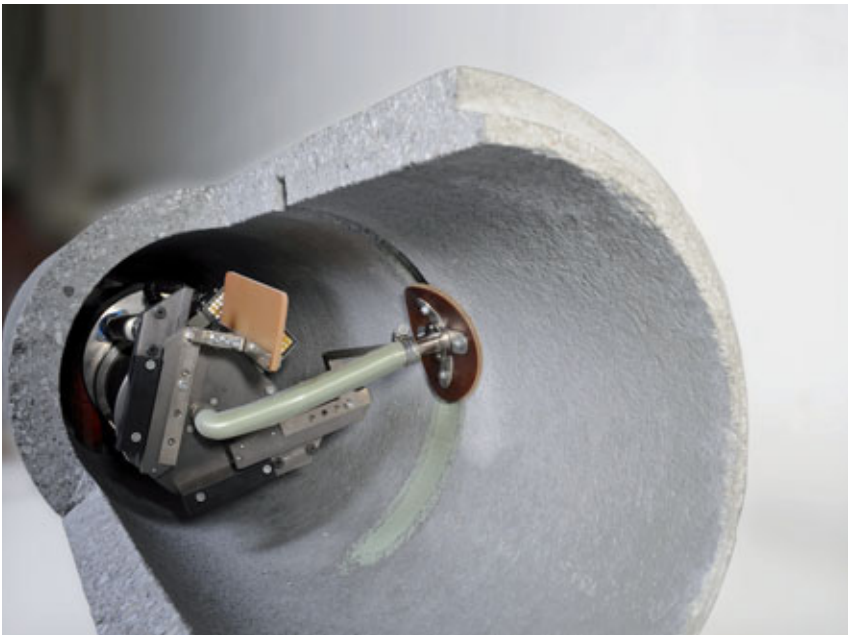
Abb. 4 Spachtelroboter beim Verspachteln eines zuvor gefrästen Querrisses (Modell)
