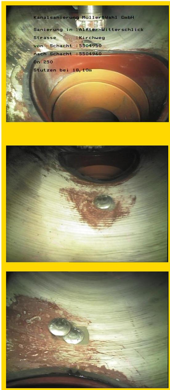
Schadenbereich aufgefräst und mit 2-K Epoxidharz mit dem KA-TE Verfahren verspachtelt.
