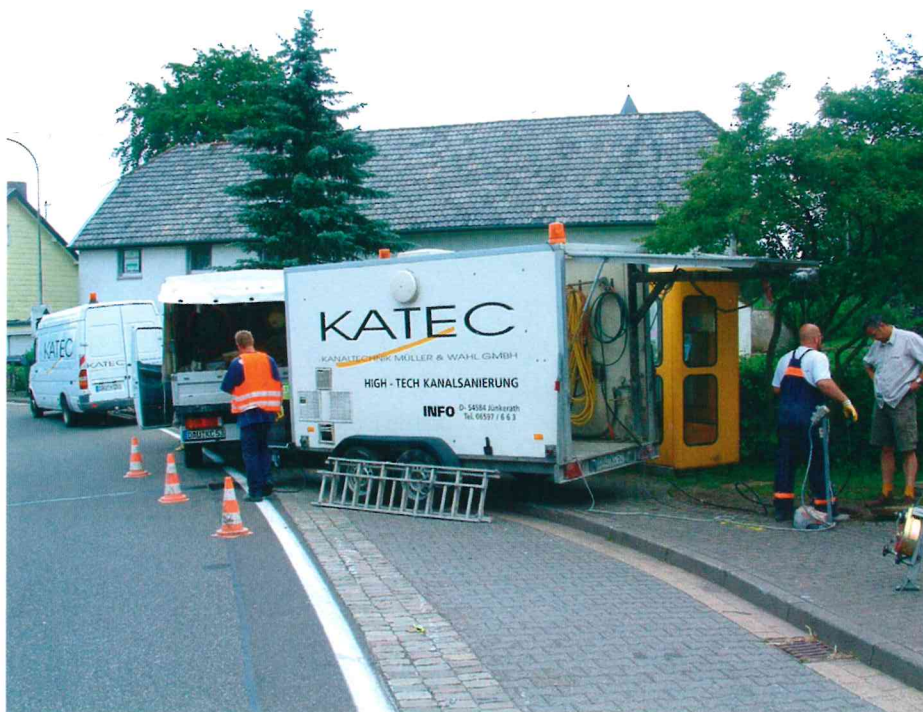
In der Eifelgemeinde Hellenthal-Hollerath hat die Katec-Kanaltechnik Müller & Wahl GmbH 2007 insgesamt 60 Schachtbauwerke mit der KS-ASS-Technik von Hermes und den dazugehörigen Ergelit-Trockenmörteln saniert. Nach zehn Jahren wurden die Schächte begutachtet.
