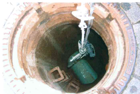
Untergrundvorbehandlung durch Wasserhöchstdruck-Reinigung
