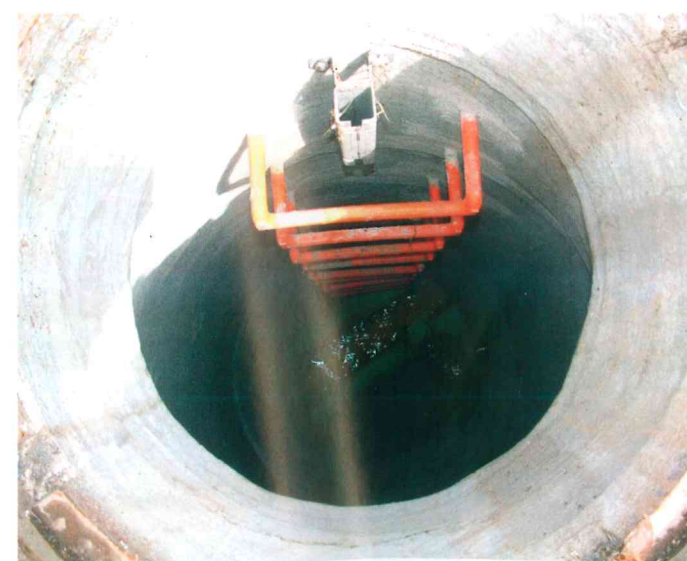
Mit Ergelit-KS1 beschichteter Schacht | Fotos: IKT
